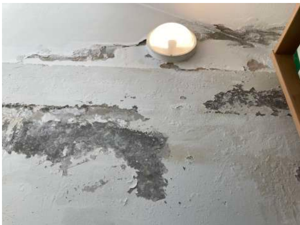
Viste interne: autorimessa e particolari delle parti ammalorate
